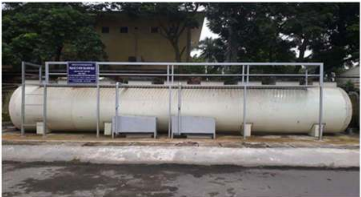
Hình ảnh: Hệ thống xử lý nước thải công suất 30 m 3 /ngày.đêm tại 3 nhà máy thực ăn chăn nuôi KCN Khắc Niệm
